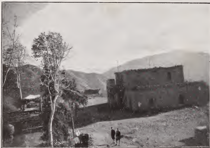
PALACIO EN CONSTRUCCION Y TEATRO AL AIRE LIBRE DE LA MISION CULTURAL
